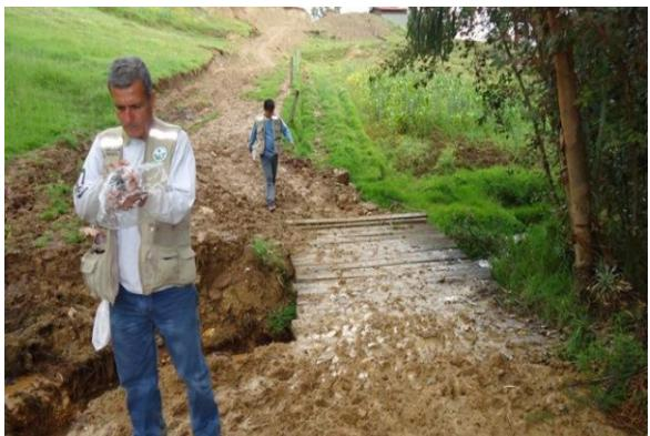
Foto 09: Pontón de Madera en Mal Estado, Km. 8+250
