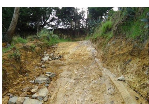
Foto 06: Falta de Cunetas y Perfilado del Camino KM 2+200.
