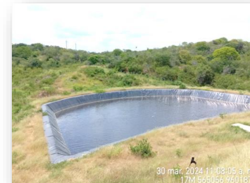
Contar con sistema de almacenamiento y manejo de lixiviados operativos
