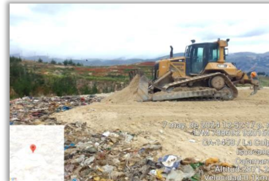
Cobertura diaria de los residuos sólidos con capas de material de cobertura para el correcto confinamiento de residuos
