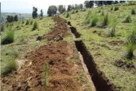
Limpieza de zanjias de infiltración
