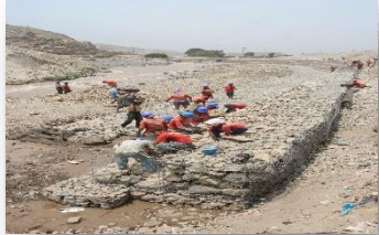
Protección de márgenes de ríos y quebradas con rocas al volteo
