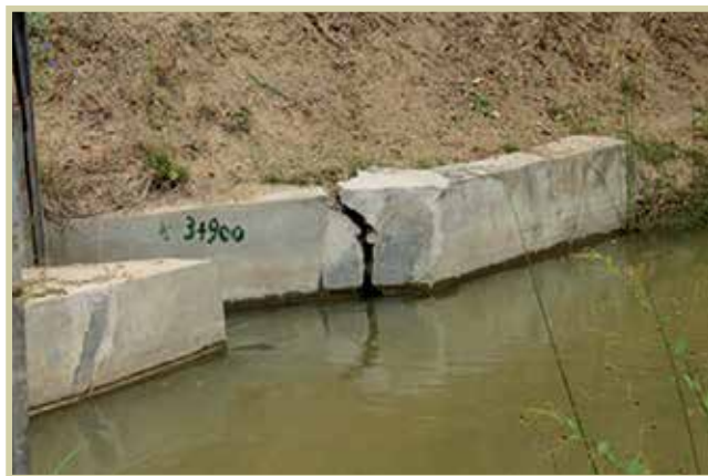
Canal de riego expuesto y frágil ante probables deslizamientos. Fotografía: IPACC BMUB/GIZ.
