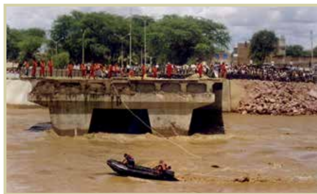
El puente Bolognesi impactado por el fuerte caudal y el material de arrastre, lo que generó su colapso, es decir, un desastre, Piura (FEN 1997-1998).
