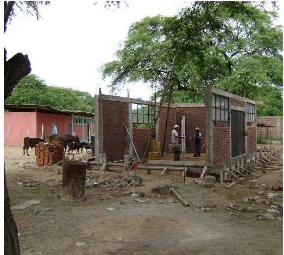
Construcción de caseta de equipo de bombeo
