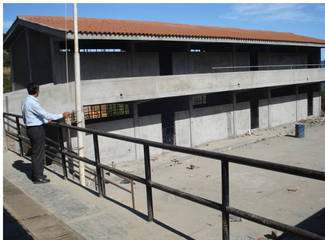
Acabado de uno de los pabellones de la I.E.
