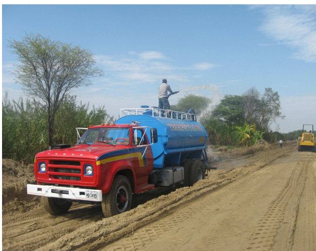
Humedecimiento del canal y compactación
