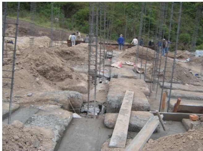
Izamiento de columnas
