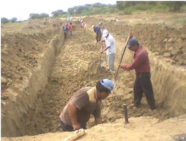
Excavación del canal
