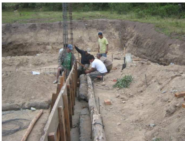
Construcción de ambientes en el establecimiento de salud
