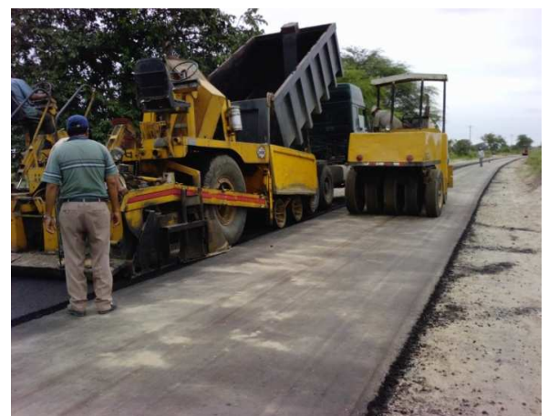
Carpeta asfáltica en caliente
