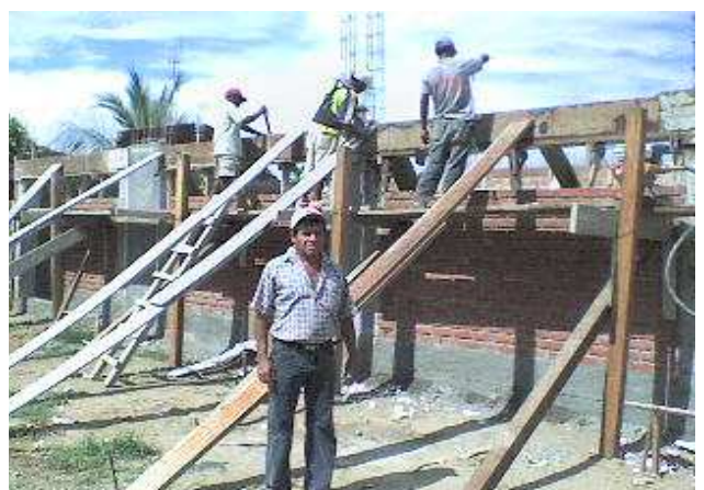
Encofrado de vigas del Aula de Usos Múltiples
