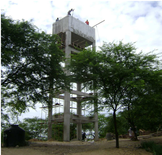
Construcción Reservorio elevado
