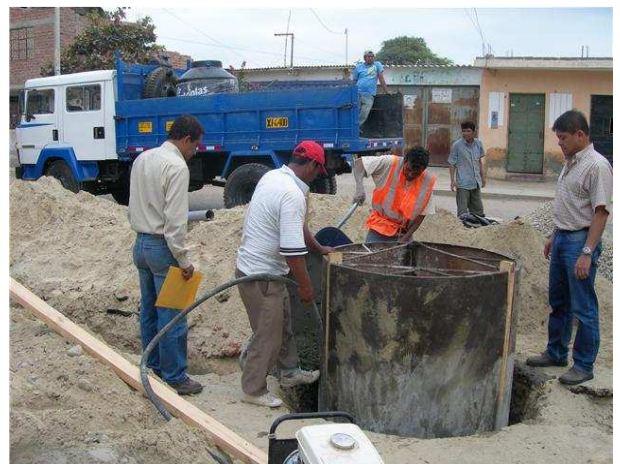
Vaciado de concreto para buzón
