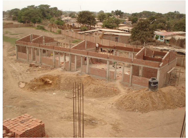
Construcción de pabellones
