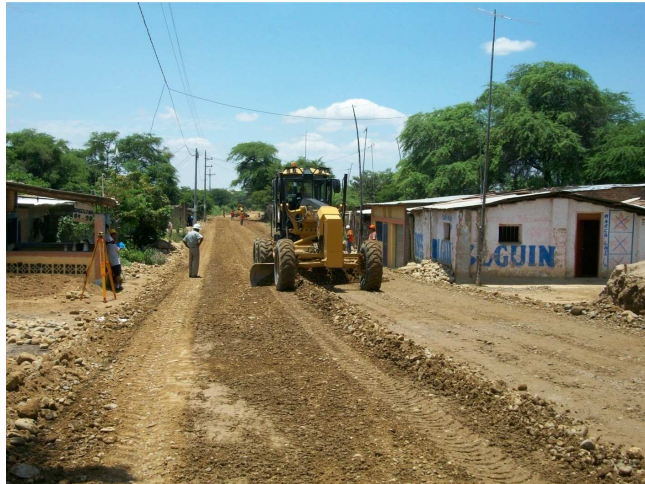
Nivelación de terreno
