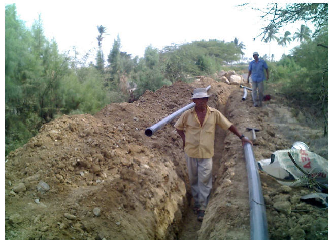
Suministro e instalación de tuberías para agua potable
