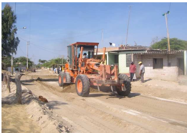
Conformación de subrasante
