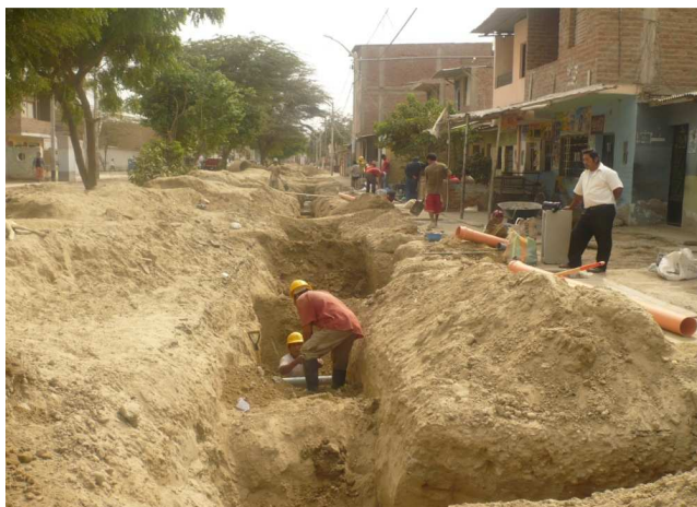
Instalación de conexiones domiciliarias de desagüe
