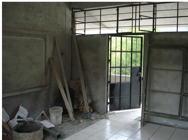
Proceso de acabado en aulas de la I.E.
