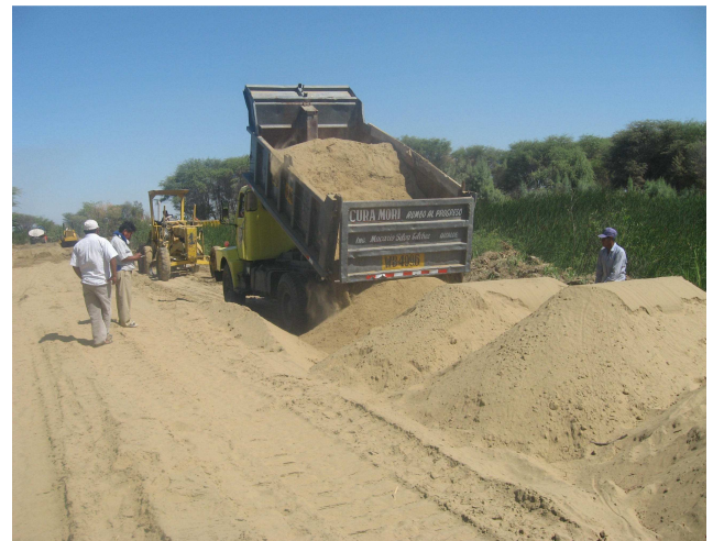
Acopio de agregado en obra
