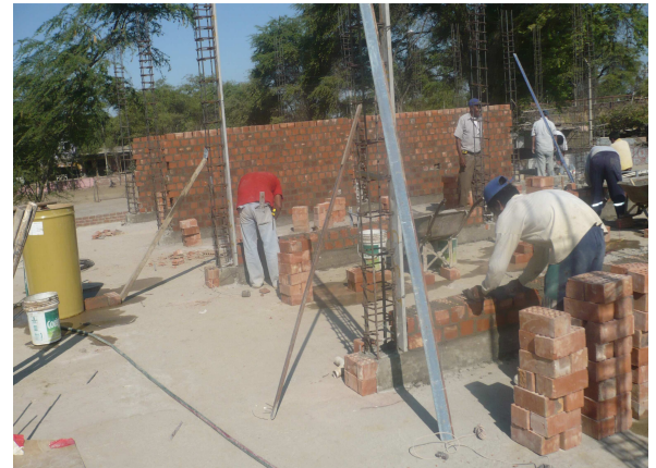
Avance en la construcción de ambientes en el centro de salud
