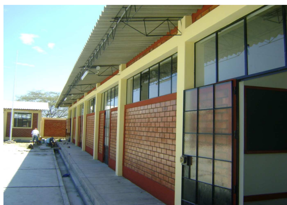
Centro Educativo concluido (aulas, cerco perimétrico y equipamiento)
