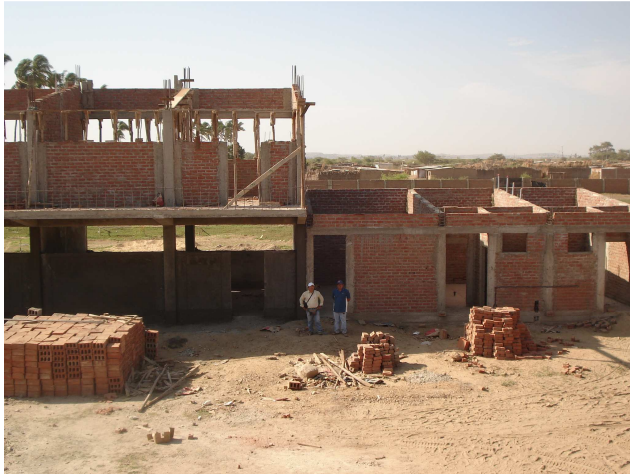
Pabellón y batería de baños en construcción
