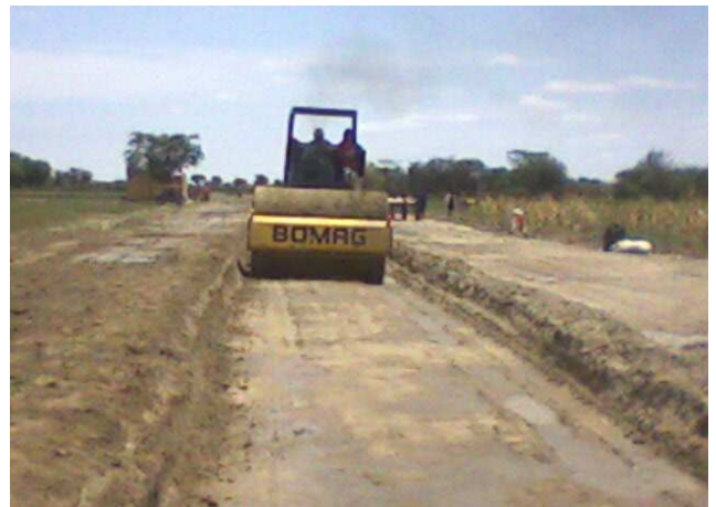
Proceso de compactación
