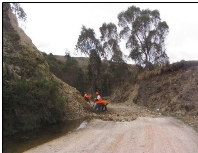
Vista actual del tramo I, sufre continuos deslizamientos a causa de las lluvias
