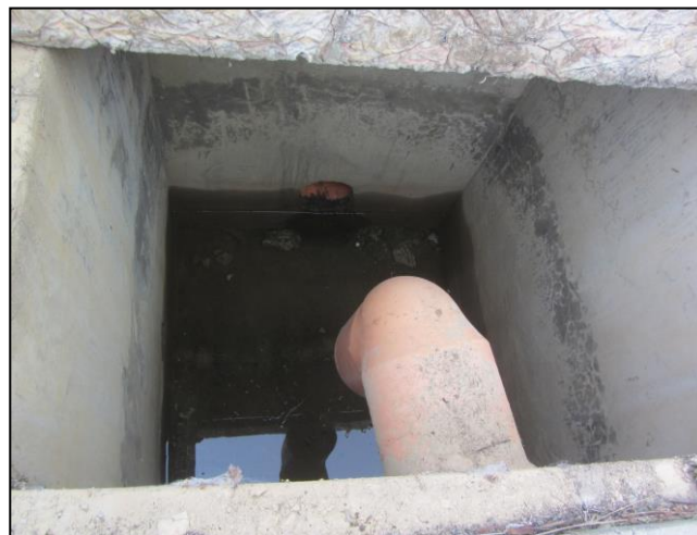
Vista del interior de la captación y rebose.
