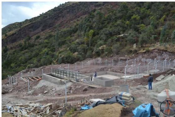
Vista del tanque Inhoff - Sedimentación
