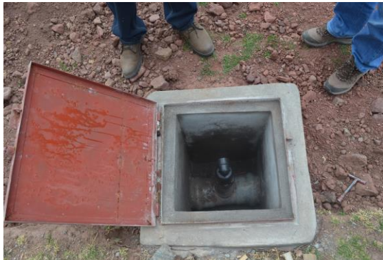
Válvula de purga y control de presión
