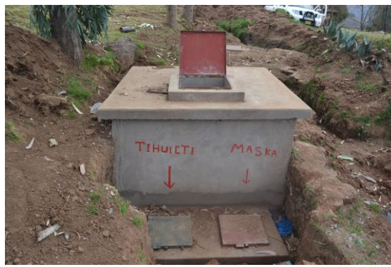
Caja de derivación del agua
