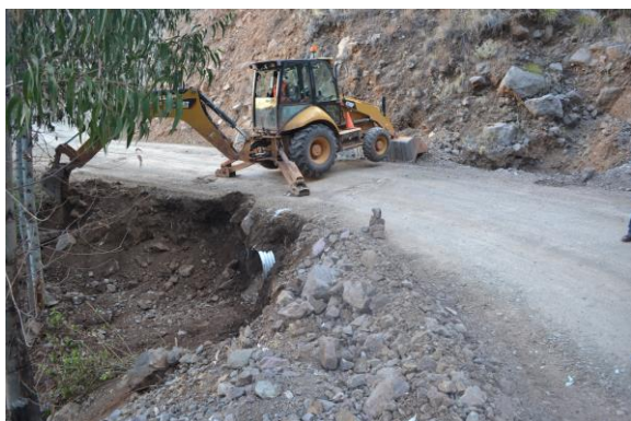
Cruce para línea de alcantarillado
