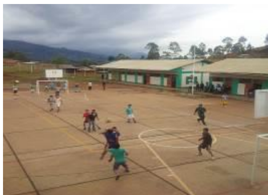
Vista de 2 pabellones y la losa deportiva
