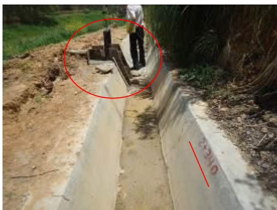
Vista del canal de concreto (Dist. de Llacanora) en la progresiva 2+340, también se aprecia la válvula compuerta en proceso de instalación.
