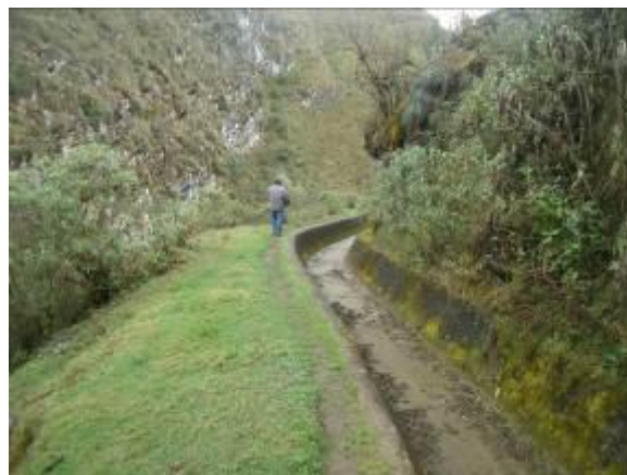
Vista del canal de regadío
