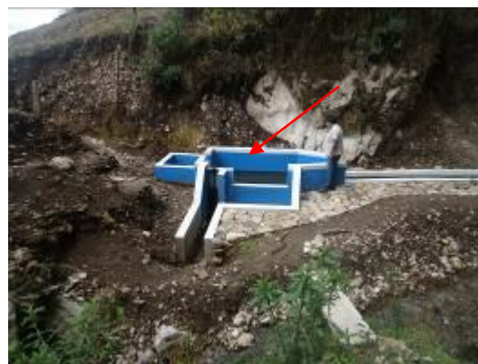
Vista de la estructura del desarenador y sistema de rebose y limpia
