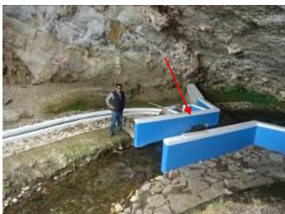
Vista de la estructura de toma ó captación.
