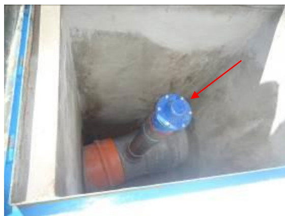
Vista de la estructura del desarenador y sistema de rebose y limpia
