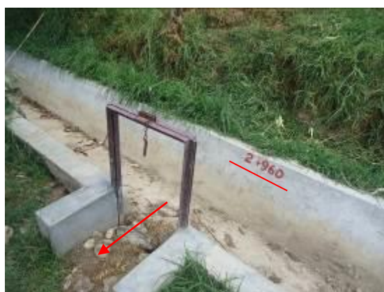
Vista de la instalación del marco de la válvula compuerta y del canal de concreto en la progresiva 2+960
