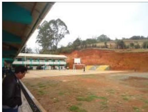
Vista del tercer pabellón, losa deportiva y del cerco perimétrico "cerco vivo"
