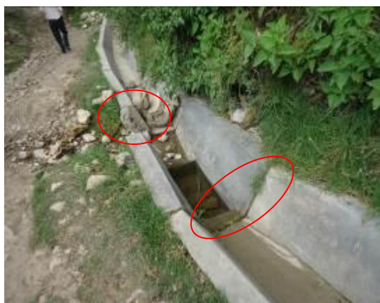
Vista del canal de concreto (Dist. de Llacanora) en la progresiva 2+340, también se aprecia la válvula compuerta en proceso de instalación.
