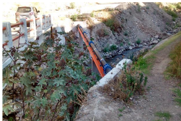
Vista de Construcción de puente aéreo de línea de conducción de agua potable
