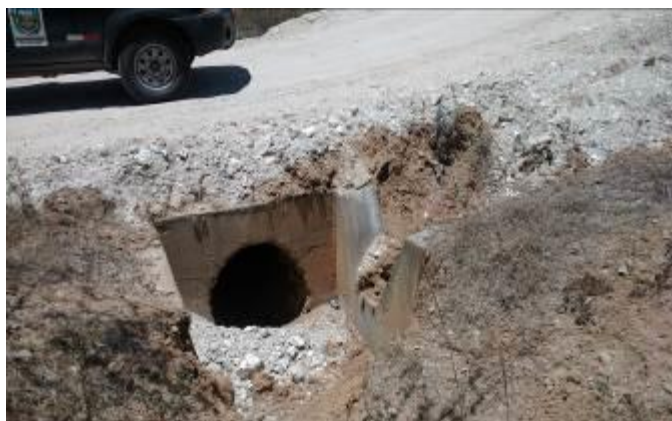
Alcantarilla construida en la trocha carrozable mejorada
