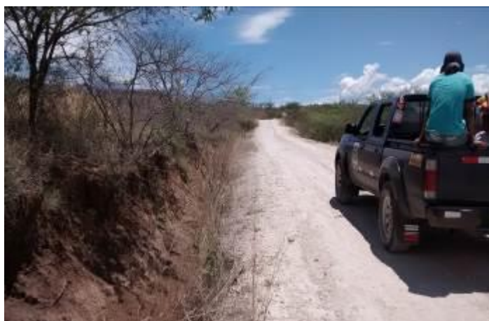
Carretera operativa se observa la cuneta
