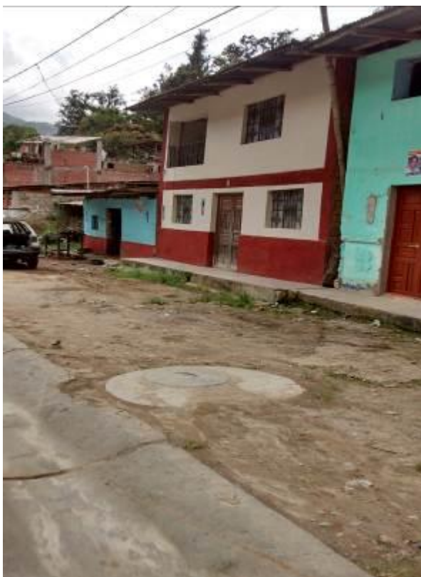
Vista de la construcción de buzones de desague
