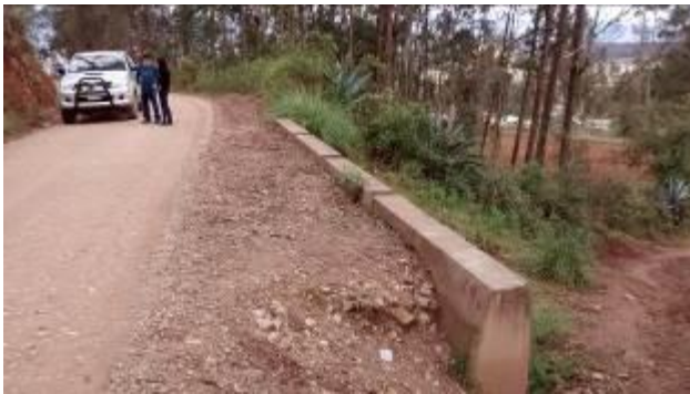
Protección construida en la carretera la cual está operativa
