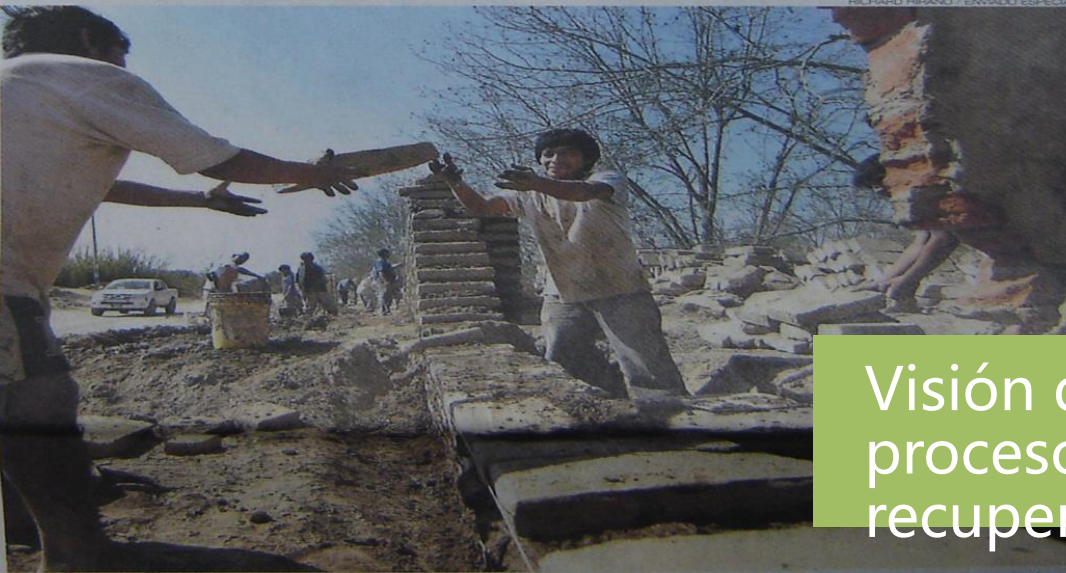
IMPRUDENCIA. Algunas personas en Ica han empezado a reconstruir sus casas con adobe, pero sin ninguna asistencia técnica.
