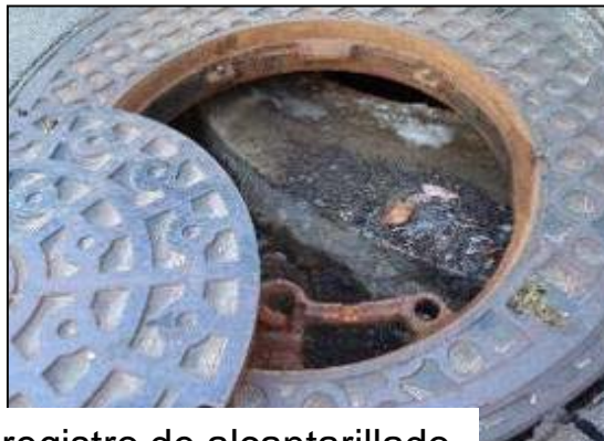
Desplazamiento de la tapa del registro de alcantarillado por deslizamientos de tierra
