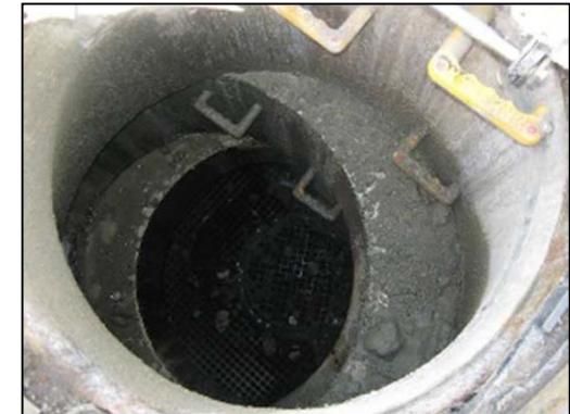
Desplazamiento de la pared vertical del pozo de registro de alcantarillado
