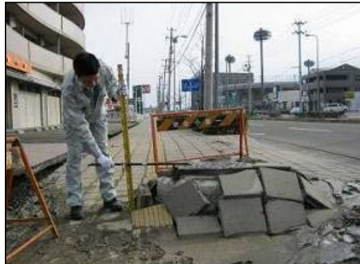
Levantamiento del pozo de registro de alcantarillado debido a la licuefacción
