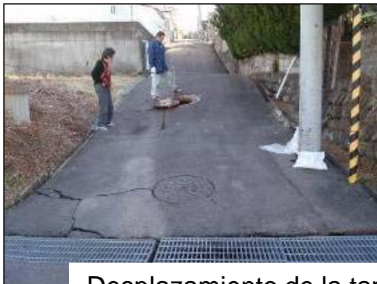
Desplazamiento de la tapa del registro de alcantarillado por deslizamientos de tierra
