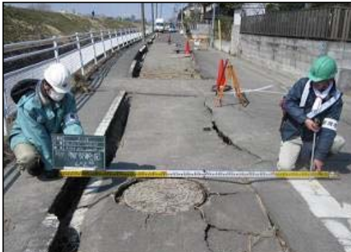
Hundimiento de las excavaciones de obras de tuberías
