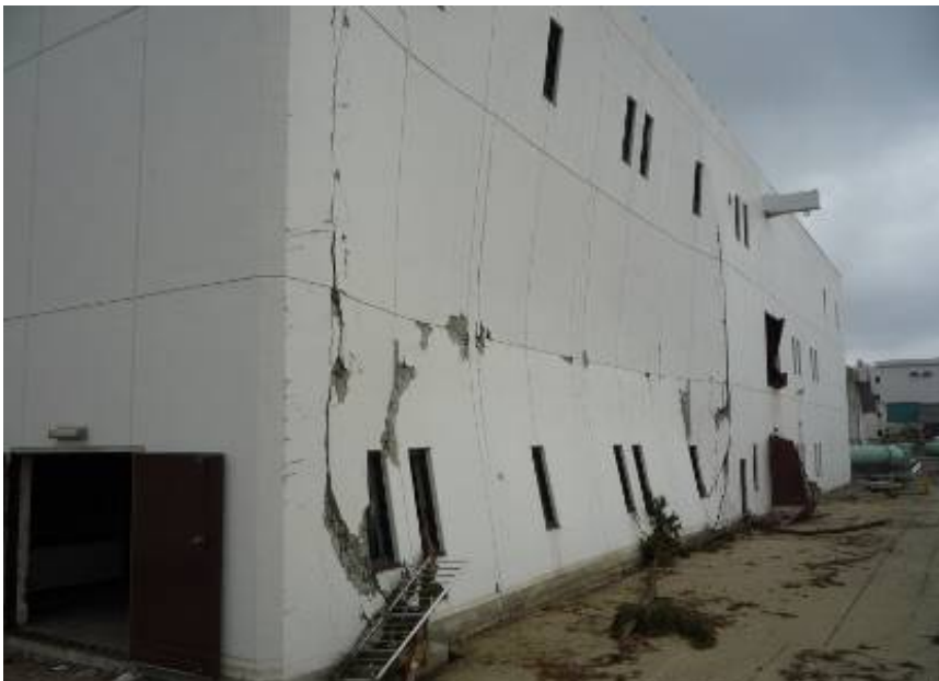
Pared de hormigón armado curvada por el tsunami
