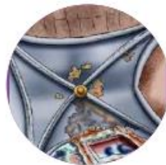
4. Filtración de agua en techos
