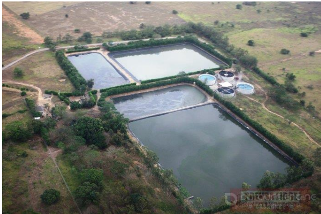
Lagunas de Estabilización
