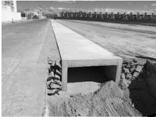
Canales Pluviales (Secciones de mayor dimensión)
