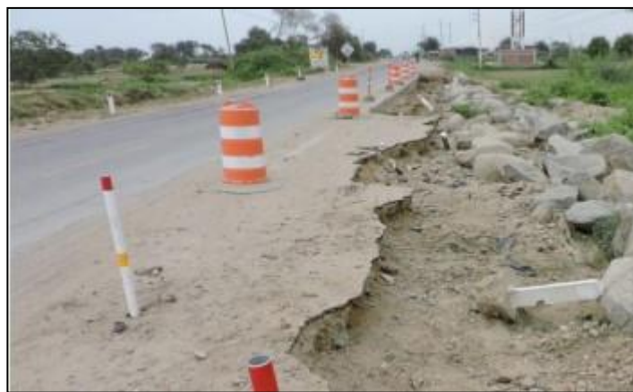
UP: Vías terrestres o carreteras
