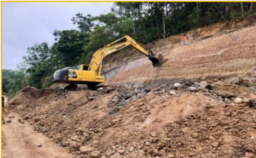
Conformación de banquetas con maquinaria
