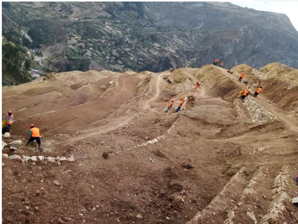
Conformación de banquetas con mano de obra
