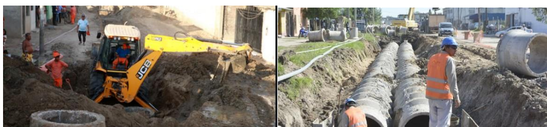
Figura N° 113 : Pantalla de fotografías de obra de saneamiento
