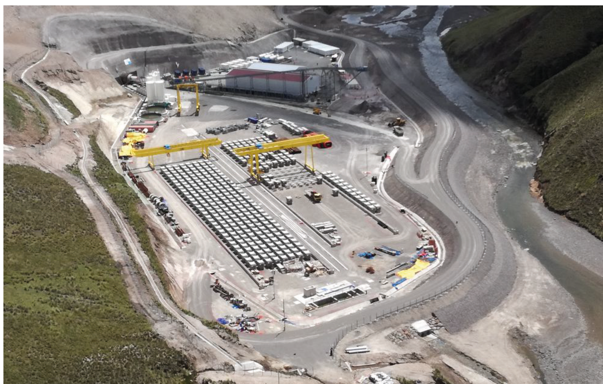
Foto: Arequipa - Proyecto Majes Siguan II etapa. Plataforma Chalhuanca, patio de operaciones de inicio perforación tunel trasandino aguas arriba. CUI: 2088142.
