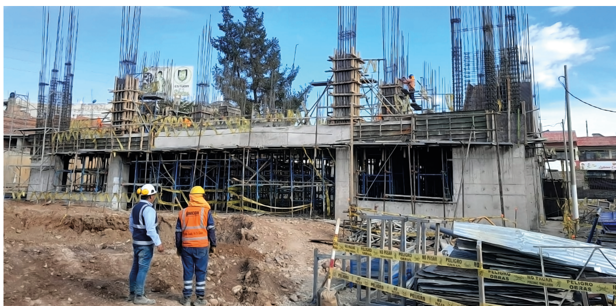
Foto: Huancayo - Mejoramiento de la I.E. Mariscal Castilla. CUI: 2200807.
