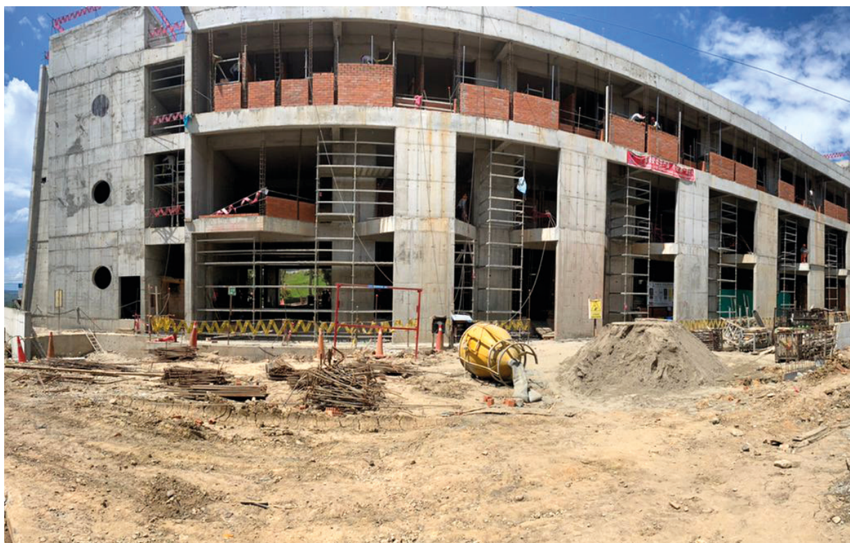
Foto: Cajamarca: Construcción e implementación del hospital II-1 de San Ignacio.
