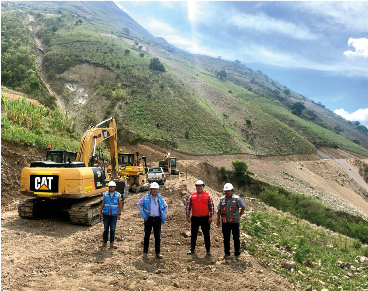
Foto: Cajamarca: Creación de la carretera Huallangate - Vista Alegre - Susangate - San José, distrito de Chota, provincia de Chota. CUI: 2205256.
