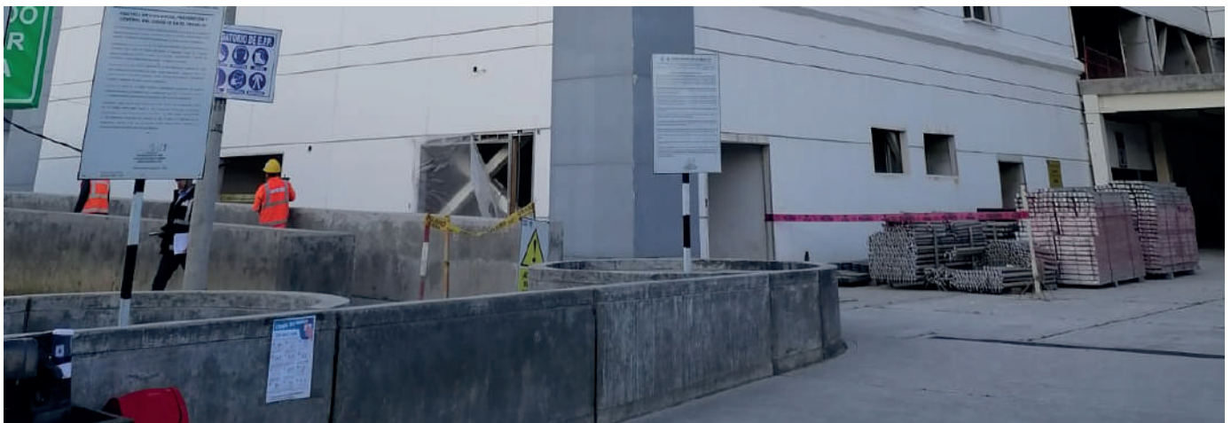
Foto: Junín - Mejoramiento de la capacidad resolutoria del hospital El Carmen, distrito de Huancayo. CUI: 2164051.
