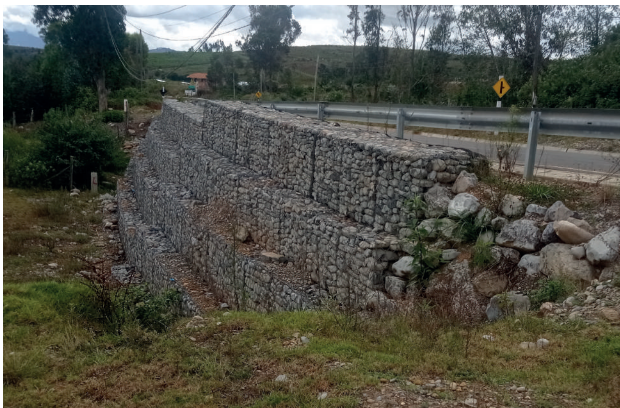
Foto: Amazonas - Mejoramiento de la carretera Chachapoyas - Aeropuerto. CUI: 2230317.
