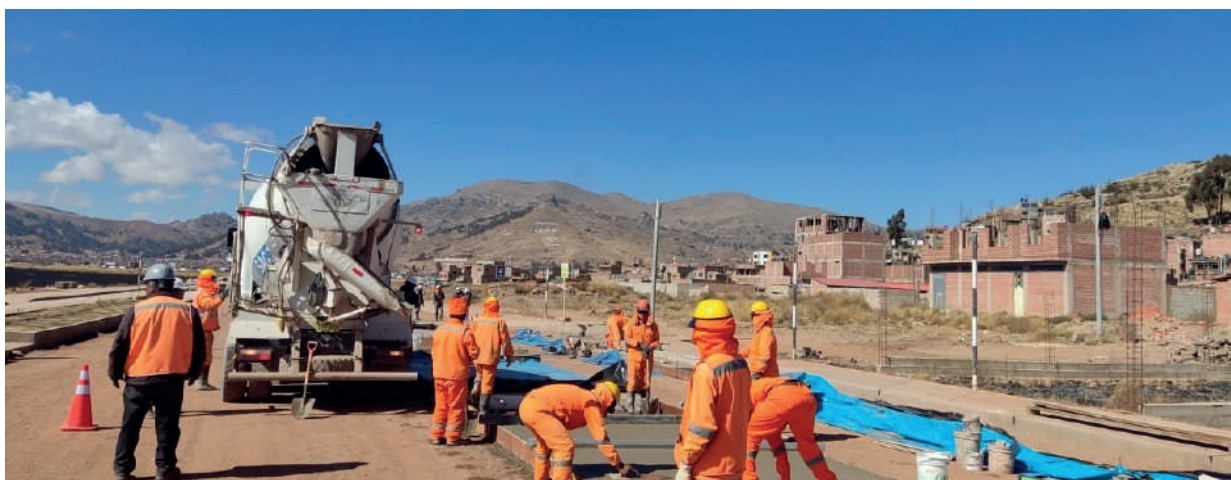
Foto: Puno - Mejoramiento y creación de la Av. Costanera Sur y Sureste en el Tramo Jr. Luis Bancho Rossi – Jr. Espinar - Panamericana Sur intersección vial Av. del Estudiante, distrito de Puno, provincia de Puno. CUI: 2300092.
