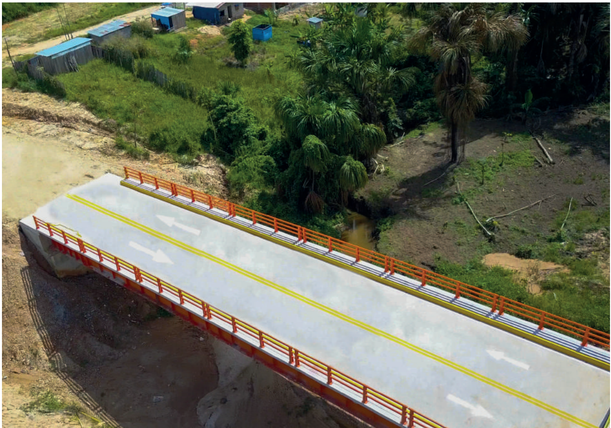
Foto: Ucayali - Creación de puente carrozable y peatonal sobre la quebrada en la Av. Lester Dionicio, ampliación Nueva Requena del distrito de Nueva Requena, provincia de Coronel Portillo. CUI: 2471130.
