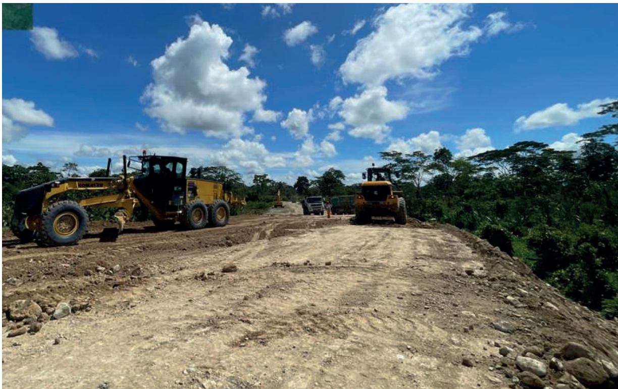
Foto: San Martín - Creación del puente vehicular Jorge Chávez sobre el río Chontayacu y accesos en la localidad de Jorge Chávez del distrito de Uchiza - provincia de Tocache. CUI: 2469545.
