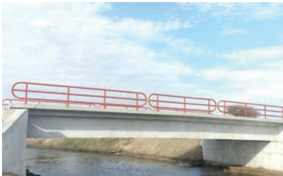
Reparación del sistema de drenaje; en el Dren Sechura, distrito y provincia de Sechura. CUI: 2527371.
