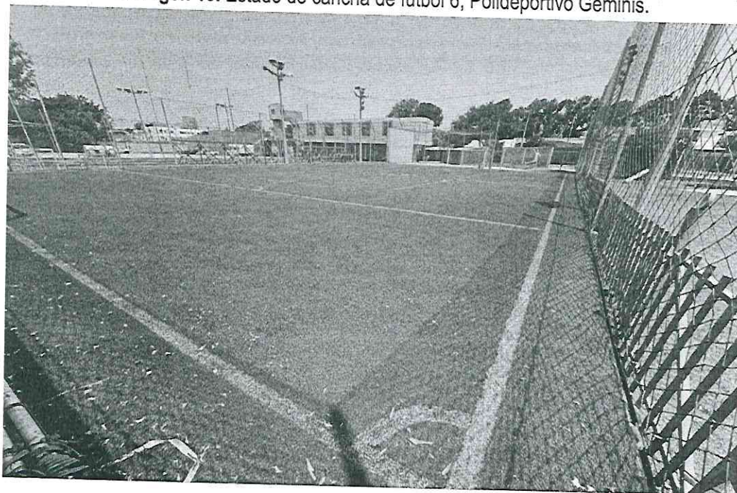
Imagen 15. Estado de cancha de fútbol 6, Polideportivo Géminis.
