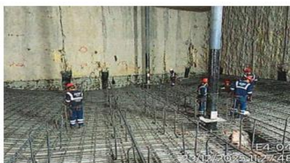
Armado de acero para losa de fondo en la Estación E4-4 "Aeropuerto", del Ramal Línea 4
