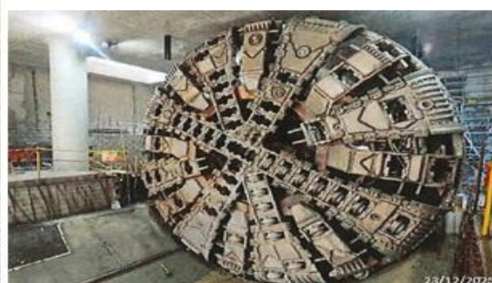
Paso en vacío de la TBM1 en la Estación E-7 "San Marcos"
