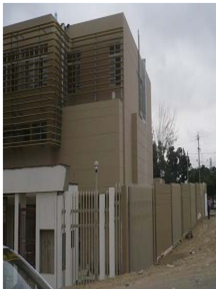
VISTA DE LA ESQUINA LA CALLE ARECHUA - CASTROVIRREYNA
