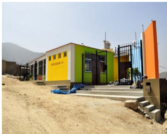
Ampliación de Aulas IE Inicial 8183 – Pitágoras en las Lomas de Zapallal Convenio 16-2010-0018 Dpto. Lima; Prov. Lima; Dist. Puente Piedra
