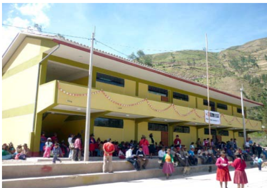
Construcción Aulas IE 54344 Virgen del Carmen Convenio 24-2009-0013 Dpto. Apurimac, Prov. Aymaraes; Distrito San Juan de Chagña.
