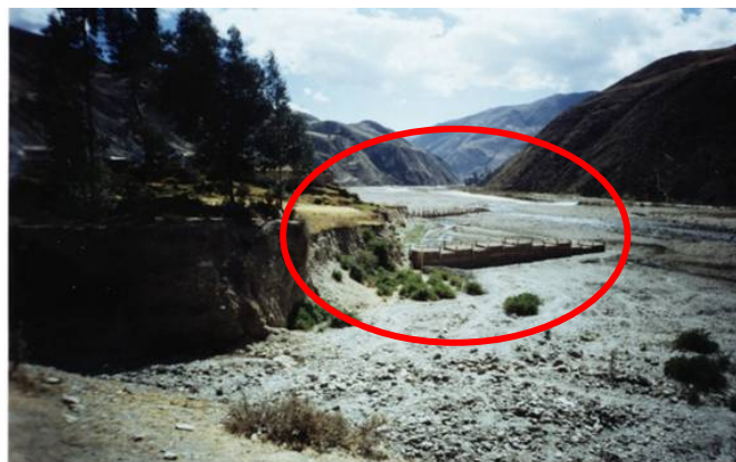
Obra: "Encauzamiento en la Cuenca del Mapacho: tramo Marjupata - Ccapana" Espigones de rollizos de eucaliptos terminado
