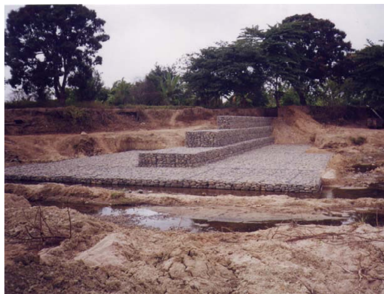
PROTECCION DE RIBERA Gaviones Sector PALMA I Zarumilla. Cortesía PERPEC
