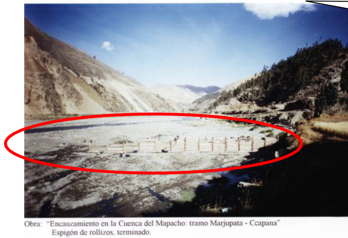
Obra: "Encauzamiento en la Cuenca del Mapacho: tramo Marjupata - Ccapana" Espigones de rollizos de eucaliptos terminado
