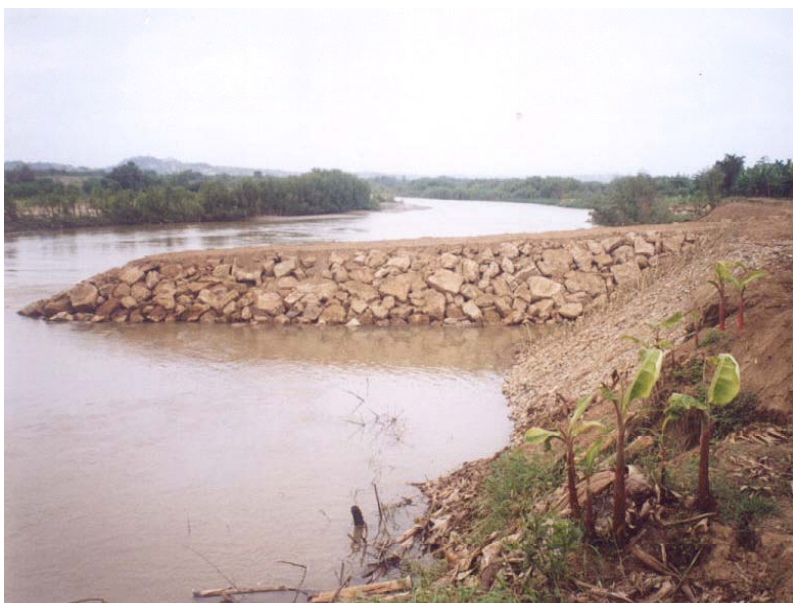
PROTECCION DE RIBERA Espigón Sector PLATEROS II Tumbes Cortesía PERPEC
