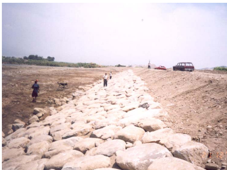
Encauzamiento-Río Moche, La Juanita, Margen Izquierda-PERPEC.
