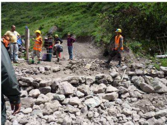
LIMPIEZA DE VÍA
