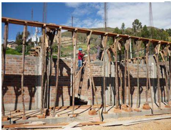
CONSTRUCCIÓN DE AULAS
