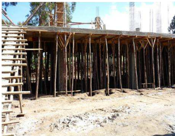
CONSTRUCCIÓN DE AULAS 2DA PLANTA
