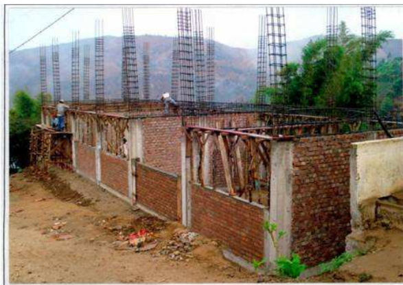
PARTE POSTERIOR PABELLÓN DE AULAS
