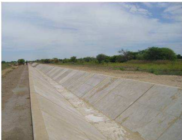
REVESTIMIENTO DE CANAL
