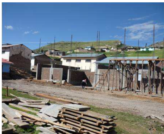
CONSTRUCCIÓN DE AULAS
