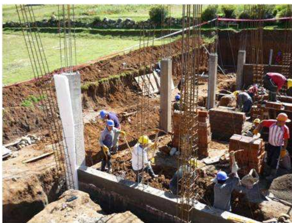
CONSTRUCCIÓN DE AULAS 1ERA PLANTA
