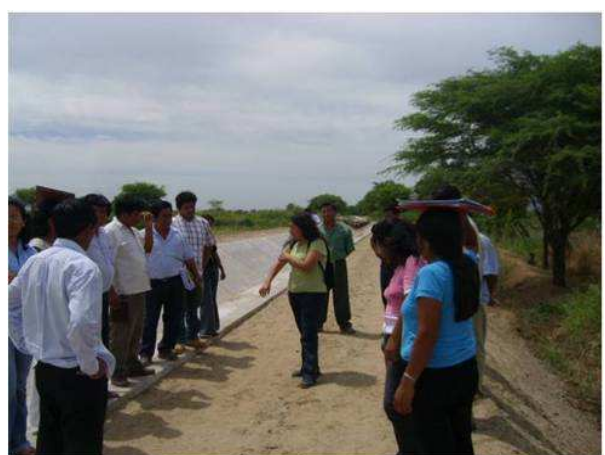
REVESTIMIENTO DE CANAL
