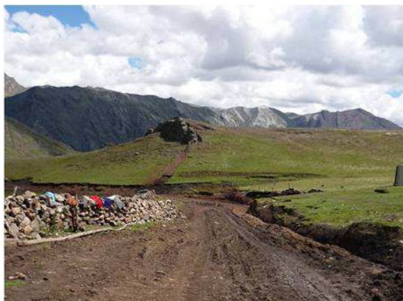
REHABILITACIÓN DEL CAMINO VECINAL
