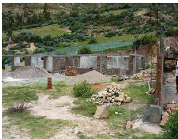
CONSTRUCCIÓN DE AULAS
