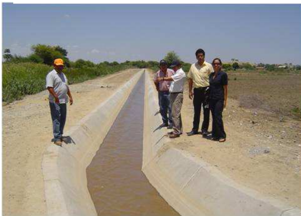
REVESTIMIENTO DE CANAL LATERAL
