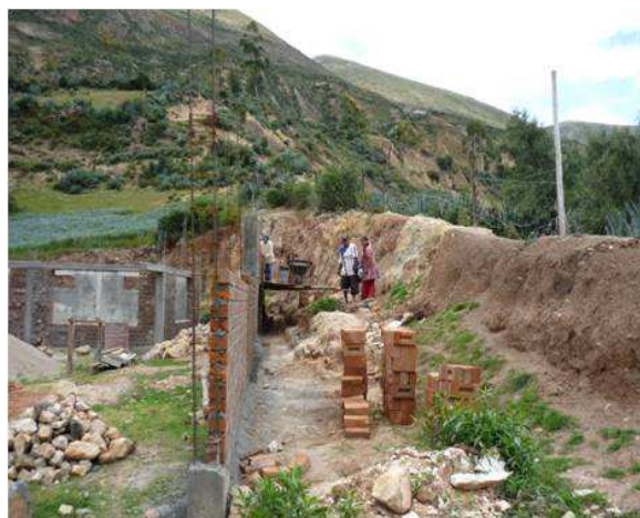
CONSTRUCCIÓN DE AULAS
