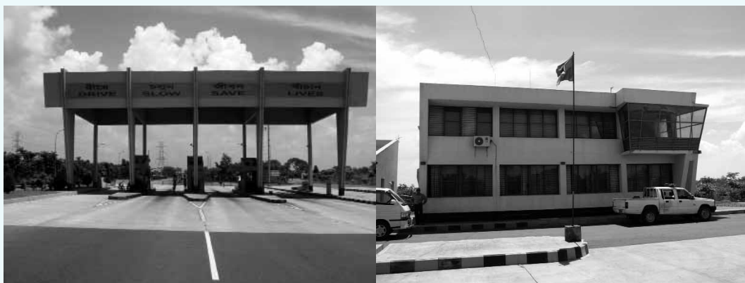
Figura 3: Cabina de peaje y edificios administrativos
